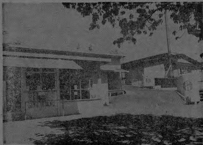
VISTA EXTERIOR Y PARCIAL DE LA PLANTA
